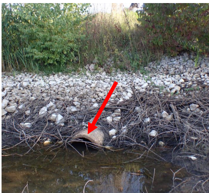
Abb. 6: Zulauf Betonrohr vom Mittleren Barthelweiher in den Unteren Barthelweiher
